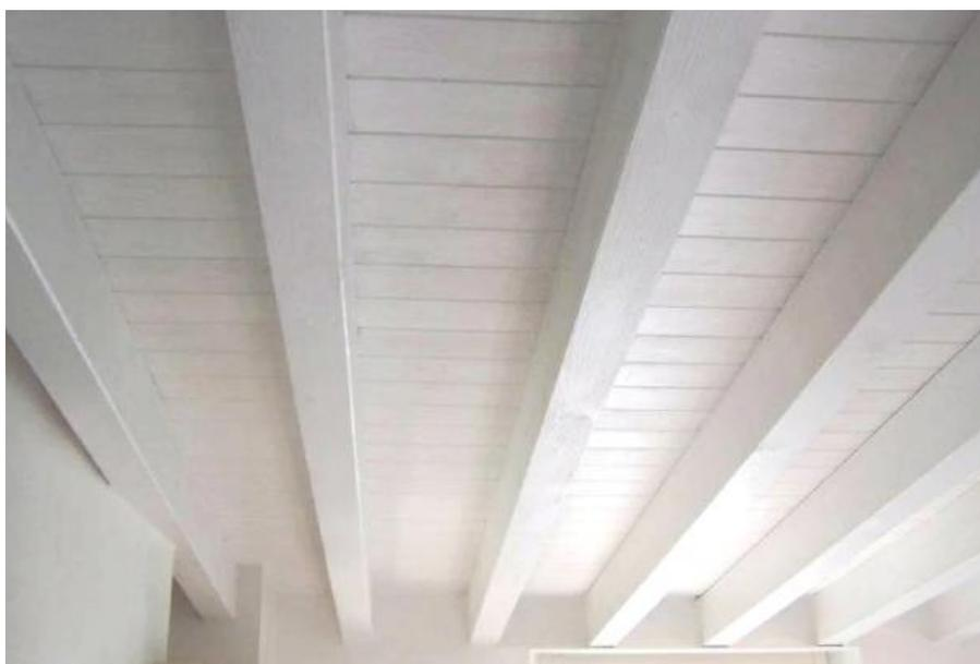
armato. La parte interna dei solai sarà rivestita in travetti in legno sp.cm 10/12, perline
