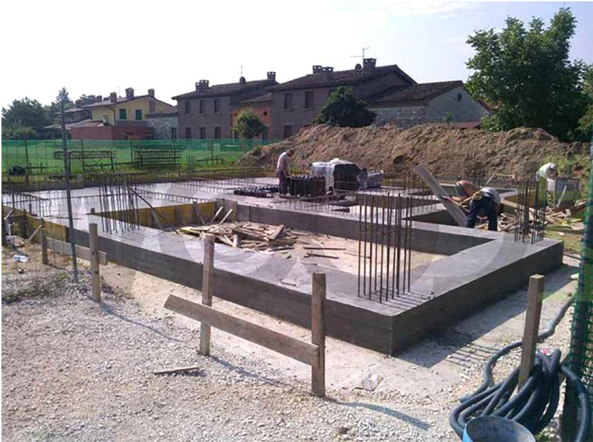
Lo scavo di sbancamento o a sezione obbligata , sarà realizzato con mezzo meccanico per la profondità necessaria a raggiungere il terreno idoneo per far luogo a getti di sottofondazione e/o fondazione determinato dall'indagine geologica a cura di un professionista abilitato. Tutti i
