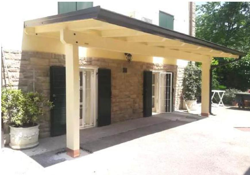
secondo le scelte e valutazioni progettuali. La struttura portante sarà costituita da pilastri, travi principali e secondarie in legno di abete, la copertura e superiore sarà realizzata con assito a vista , guaina impermeabile bituminosa ardesiata , manto di copertura in portoghesi , ferramenta zincata per
