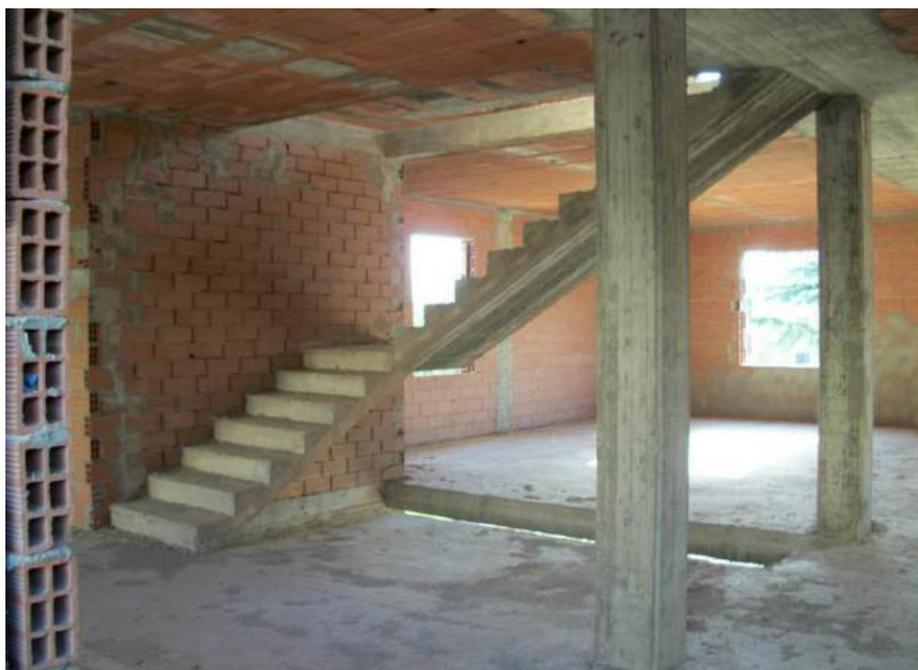
professionista abilitato nel rispetto delle normative vigenti comprese quelle sismiche, sia per i dimensionamenti (carichi e sovraccarichi), sia per i materiali di utilizzo (resistenze). La struttura verticale in c.a. sarà costituita da pilastri, setti, travi e cordoli realizzati mediante getto in opera di calcestruzzo armato di
